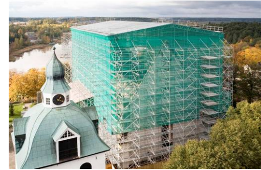
Telineet ja suojat
