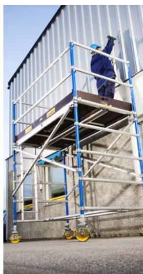
Telineet ja suojat
