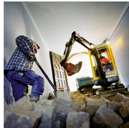
Maansiirtokoneet ja tiivistimet
