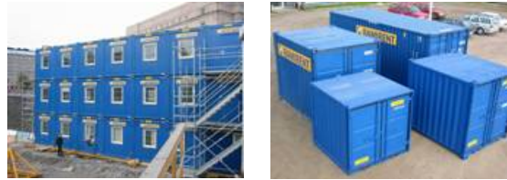
Työmaatilat ja -kontit
